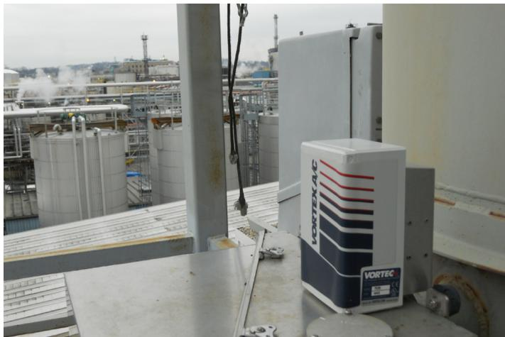
Il s'agit d'un système écologique ne rejetant pas de CFC et sans entretien puisqu'il ne comporte aucune pièce en mouvement. De plus, le système VORTEC ne crée aucune interférence dans le domaine des radiofréquences.
